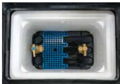
Montáž vodoměru stavební délky 165–190 mm
