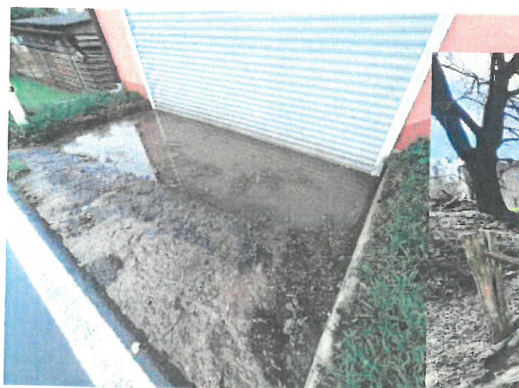
vjezd do hasičské zbrojnice
